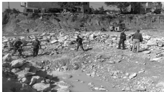
Рисунок 4 – Разрушение крепких доломитизированных известняков с коэффициентом крепости по шкале проф. М.М. Протоdjeяконова 8–10 патронами кардокс при выемке котлована для торгового центра в Болгарии
