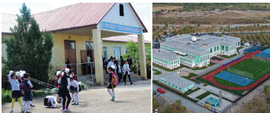
Рисунок 8 – Школа в новостройке Бишкека и школа “Газпрома”
